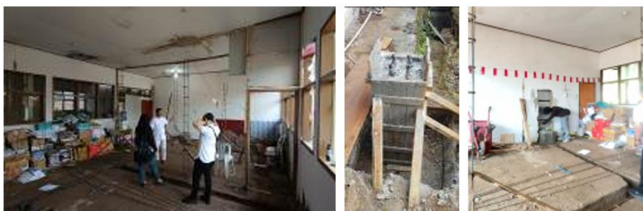
Gambar 6. Kunjungan ke Lokasi Konstruksi Ekstensi Ruang Seminar dan Ruang Aparat Desa
