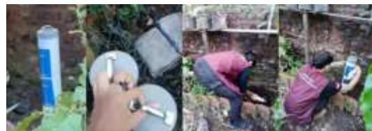
Gambar 3. Kegiatan Pelaksanaan Pemasangan LOSEDA
