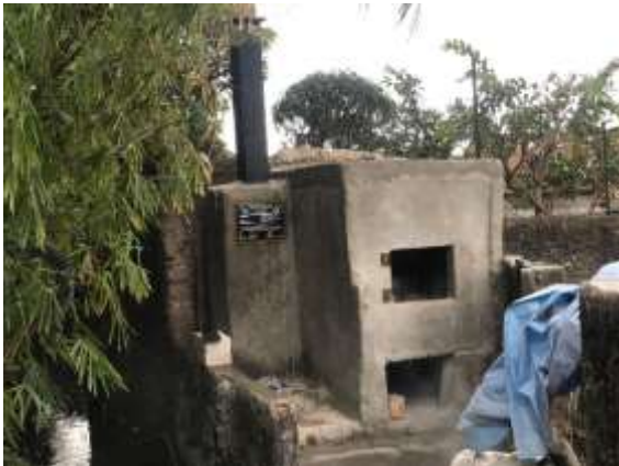
Gambar 5. Rocket Stove Setelah Dibangun
