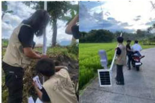
Gambar 3. Pemasangan Penerangan Lampu Jalan
