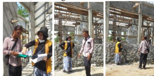
Gambar 4. Pendampingan pembangunan secara langsung oleh Abdimas
