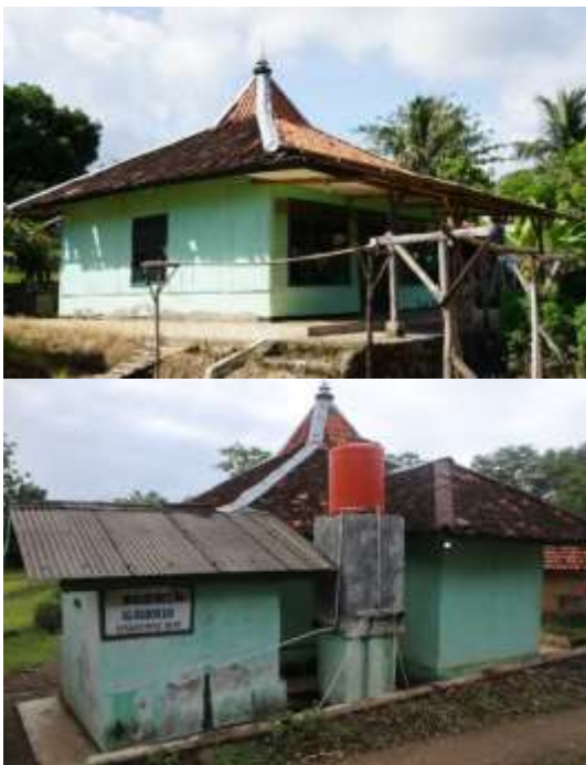
Gambar 1. Kondisi bangunan eksisting musholla Al Barokah yang akan dibangun ulang
